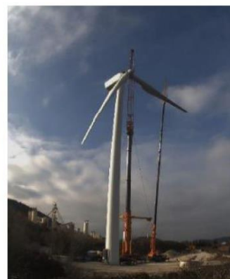
Démantèlement de l'éolienne
